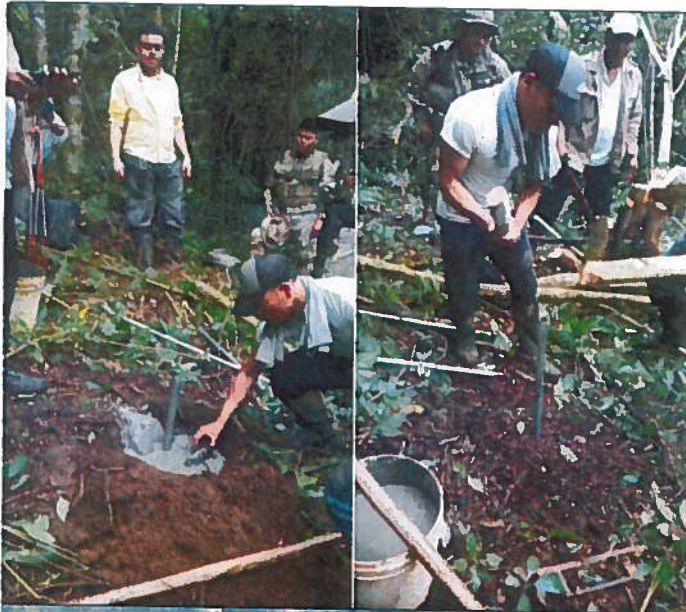
Fig. No. 5: Las diferentes comunidades de Majé Chimán, Río Hondo y Platanares, colocaron marcas en el límite de la zona de amortiguamiento del área protegida, utilizando pines de hierro o aluminio, algunos pavimentaron los puntos.
